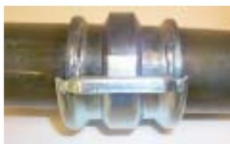
**Étape 9** - On positionne les tétons métalliques liés au joint Tuf-Lok entre les demi couvercles.
