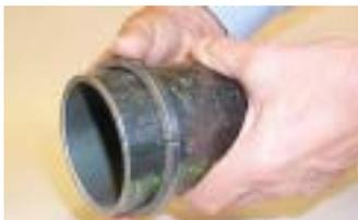
**Étape 1** - On enfle un anneau métallique de maintien Tuf-Lok sur chaque extrémité de tube, coupée d'équerre et ébavurée.
