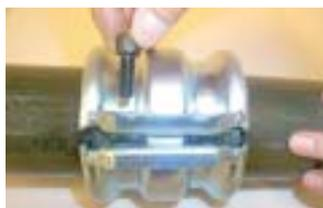
**Étape 10** - Une fois les deux couvercles métalliques Tuf-Lok positionnés sur les anneaux soudés, on les resserre de façon égale.
