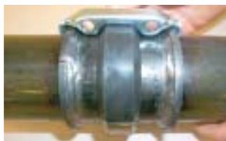
**Étape 8** - On glisse le couvercle Tuf-Lok sur les anneaux et contre le joint en caoutchouc.
