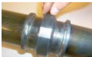
**Étape 7** - On met en contact les 2 extrémités de tube et on centre le joint en caoutchouc.
